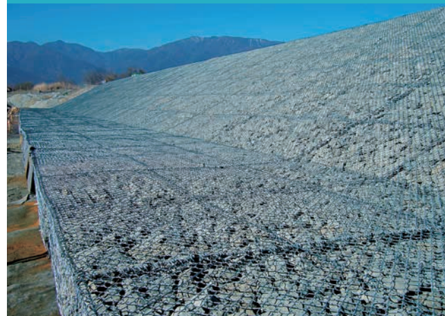
かごマットの上蓋(平張り工法)
