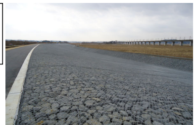
東北地方整備局 一関遊水地第1小堤 舞川地区中流
