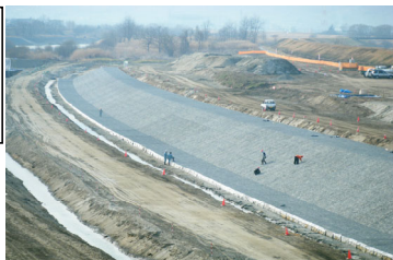
関東地方整備局 藤巻護岸工事 【国内初の新基準適合】
