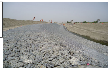
関東地方整備局 中部横断自動車道 富士川橋護岸整備工事
