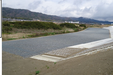
近畿地方整備局 上野遊水地服部川 越流堤工事
